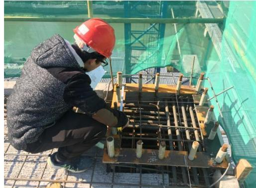
**图5.2.2.4 塑料套管固定**
