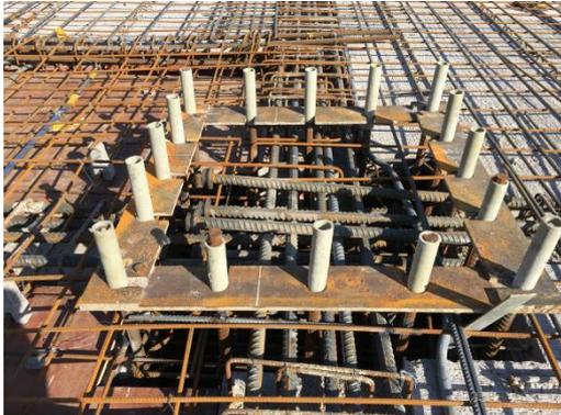
**图5.2.2.3 定位装置拼装**
