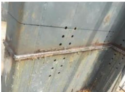
**图5.5 上、下节墙体连接完成**
