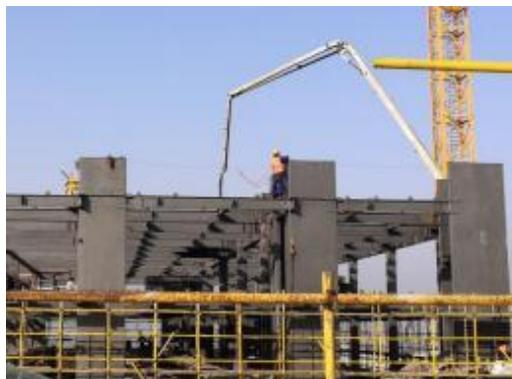
**图5.6 混凝土浇注**
