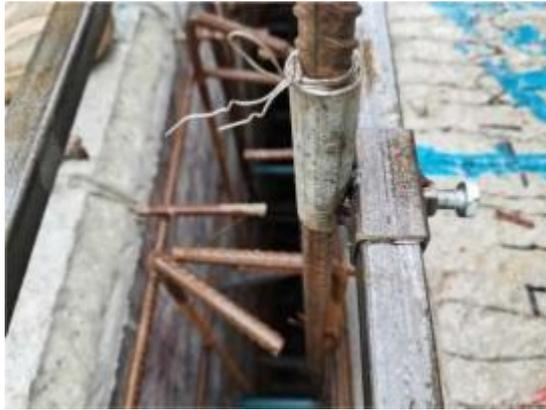
**图5.2.4 插筋下料、定位**
