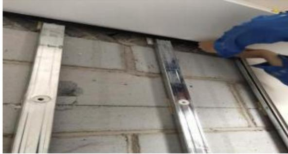
图5.2.5-2 现场顶墙收口线条安装图
