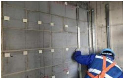
图5.2.3-2 墙面基层安装图
