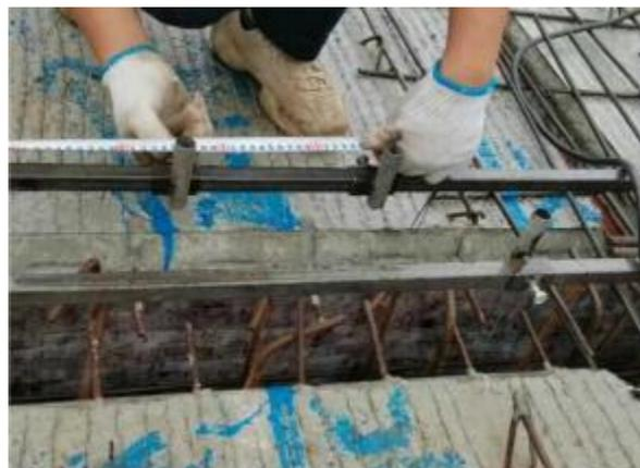
**图5. 2. 3-1 定位套管位置调整**
