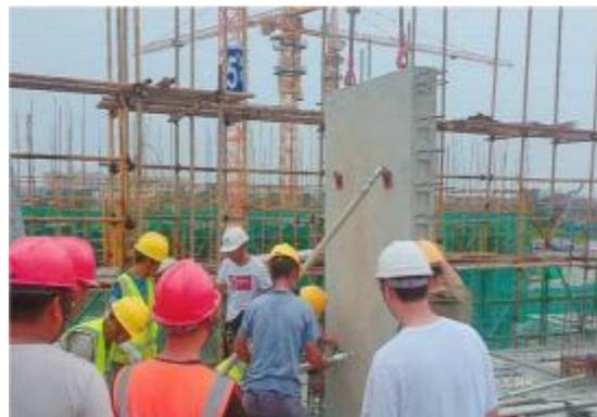
图5.2.6-4 预制墙板安装就位
