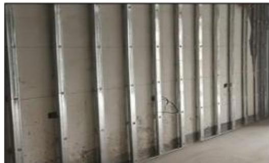
图5.2.3-3 墙面龙骨安装完成
