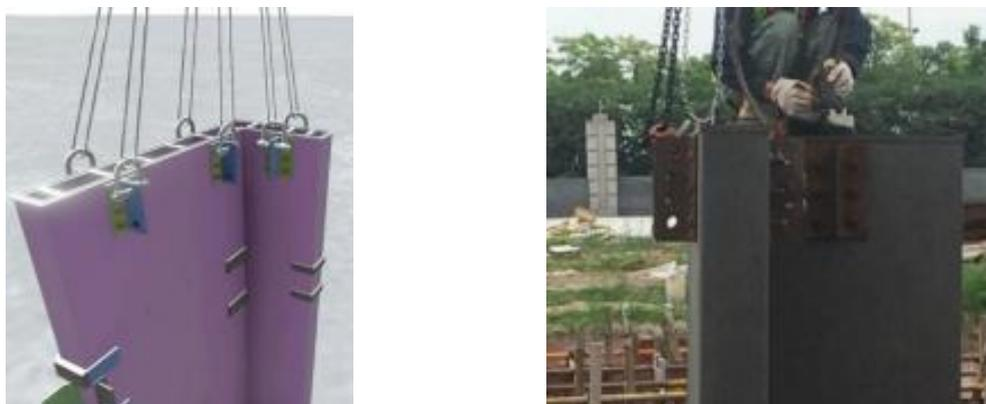
图5.3 墙体吊点设置
