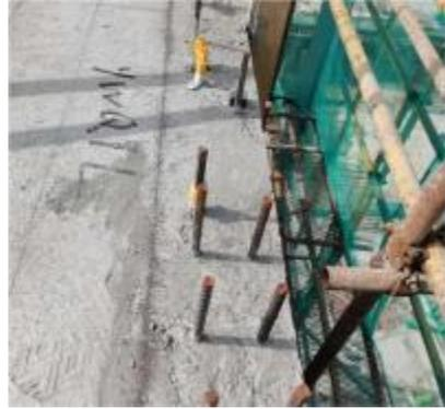
图5.2.6-2 拆除后效果(外墙)
