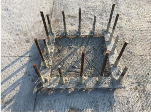
**图5.2.3 现浇层浇筑养护成型**
