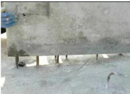
图5.2.6-3 预制墙板安装
