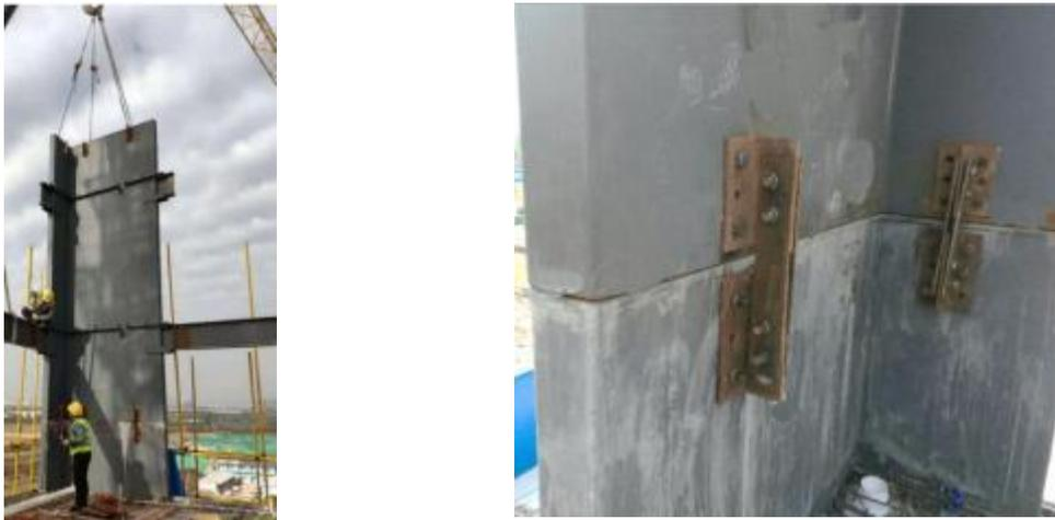
**图5.4 L型墙体安装**
