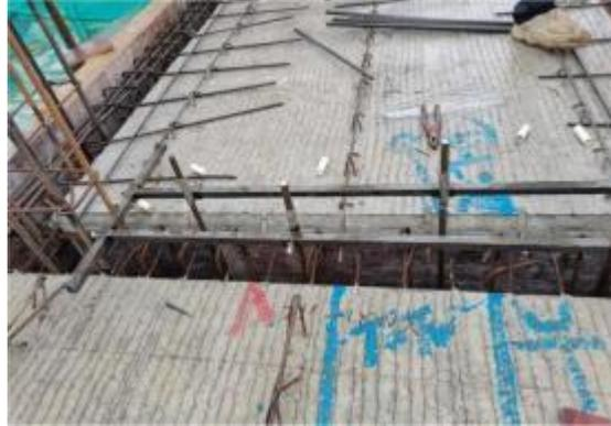
**图5. 2. 3-2 定位模具安装完成**
