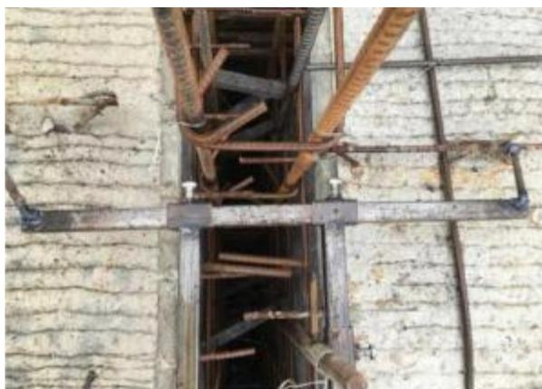
**图5. 2. 1-2 定位模具固定**
