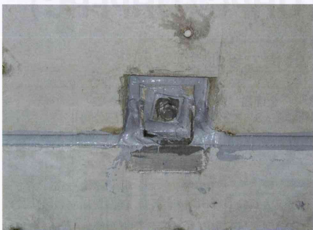
图 19 接合铁件胶条中断处需以密封胶全部填封
