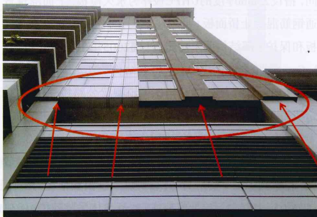
图 21 预制外墙板各垂直缝下方与金属帷幕连接处断水需施工
