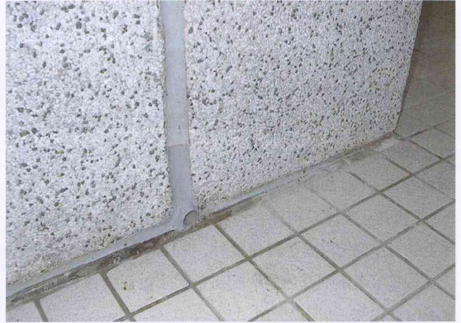
图10 排水管施工完成照片
