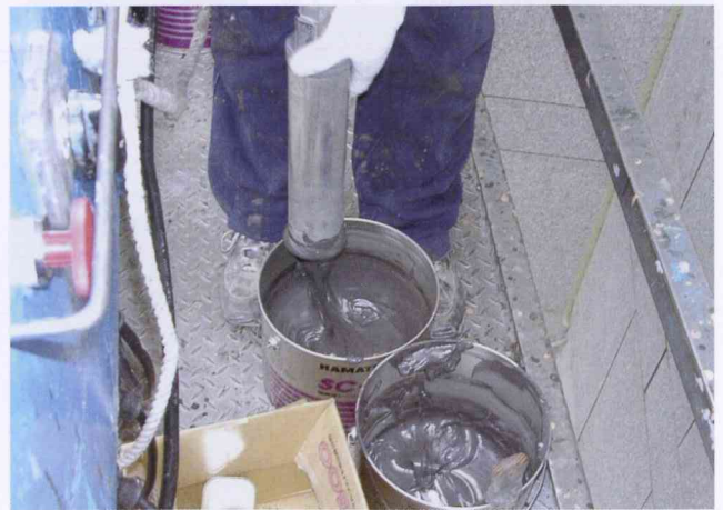
图14 以灌注枪将填缝剂慢慢吸入枪膛
