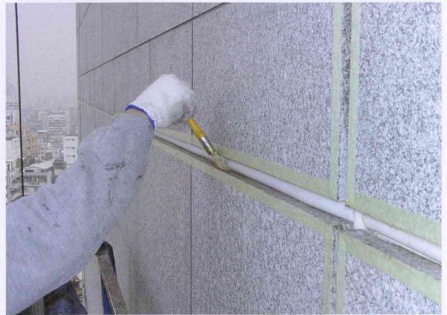
图12 在需填缝两侧涂布底剂
