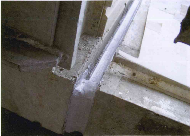
图9 PC板四周断水填缝照片
