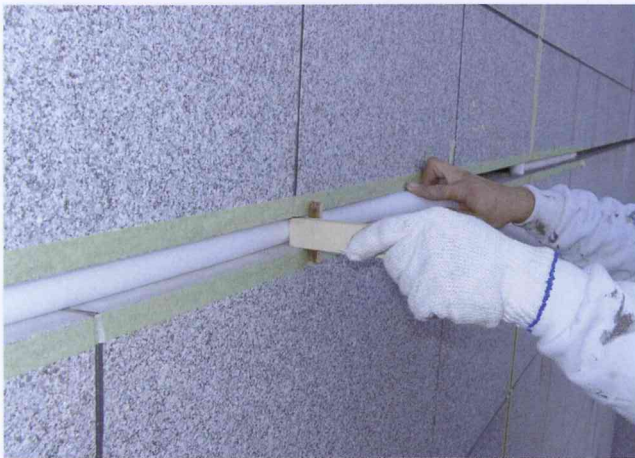
图11 以小工具控制泡棉条到要求深度
