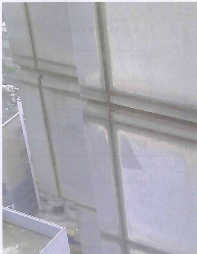
图2 因未正确保养清洗而造成密封胶污染
