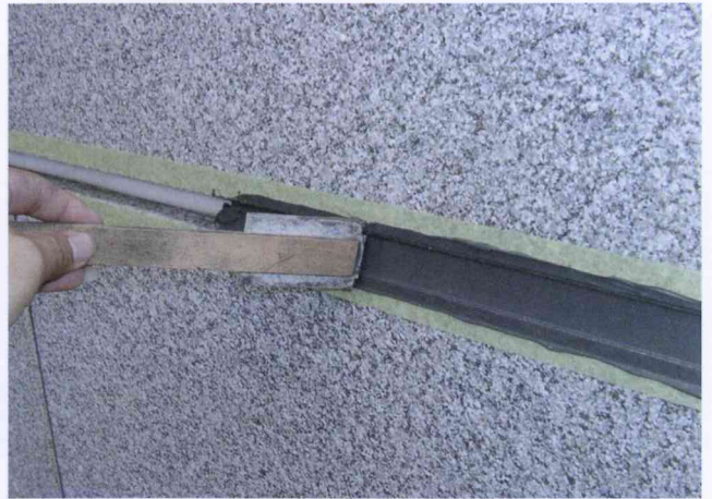
图 16 选择符合宽度深度的小工具将表面平整修饰
